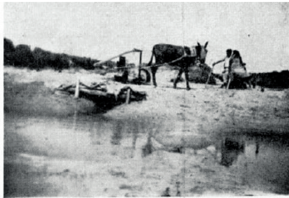
Con el fin de que los obreros hagan la limpieza de las «naves», el agua que durante el invierno las cubre, pasa, al empezar la campaña, a las «vueltas de periquillo». A tal fin se utiliza el «malacate» movido por un burro.
