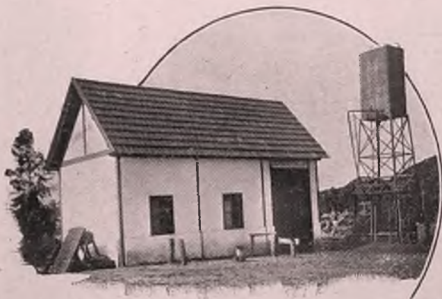
Taller y depósito de locomotora.
