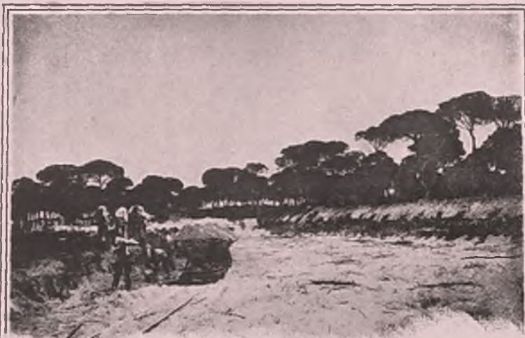
Carga de arena en vagonetas.
